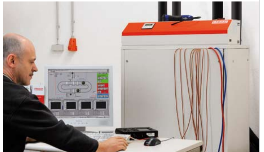
Werner Baronyai: Am Prüfstand für Wärmepumpen.
