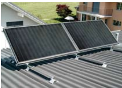
Welleternit-Aufständigung
