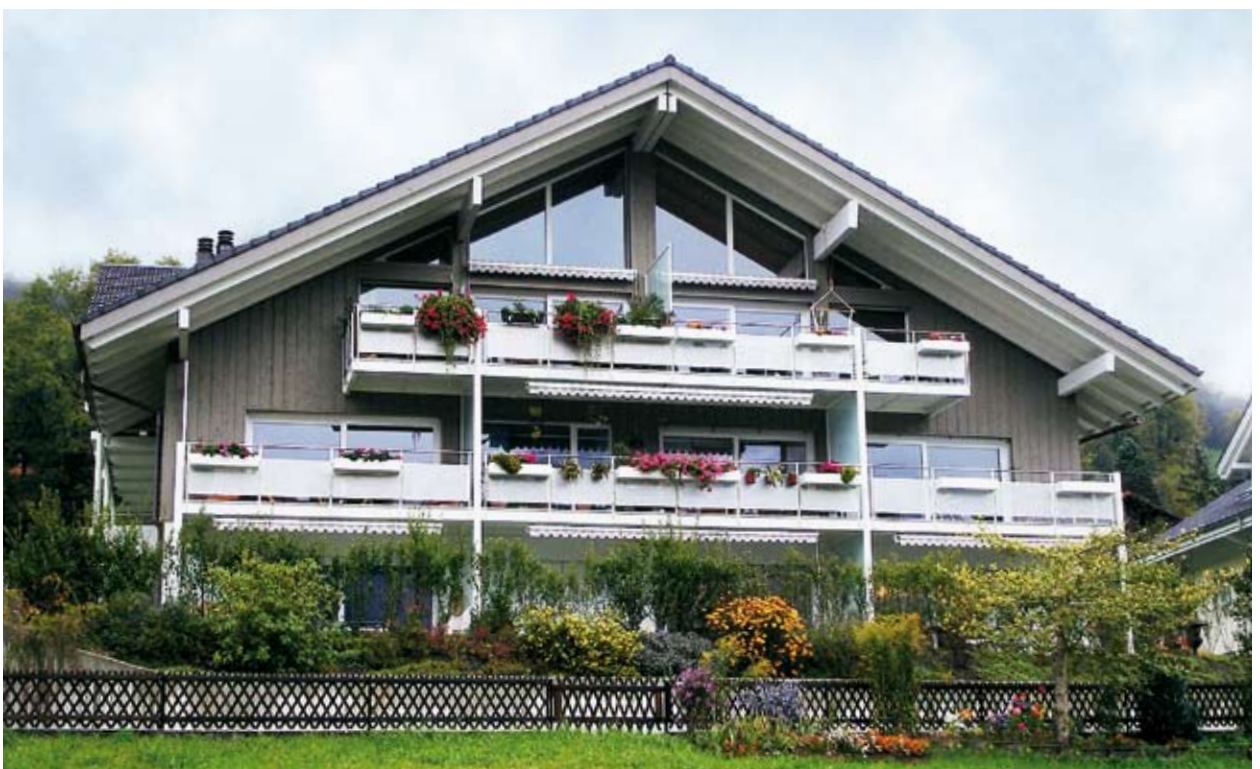
MINERGIE® Mehrfamilienhaus mit FRIAP-INTEGRALSYSTEM am Gassenweg in Ringgenberg, 1 MFH (8 Wohneinheiten)
