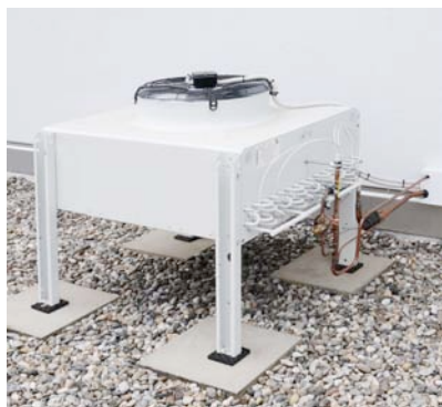
Splitverdampfer (Tischmodell) auf dem Garagendach. Abluft entweicht nach oben.
