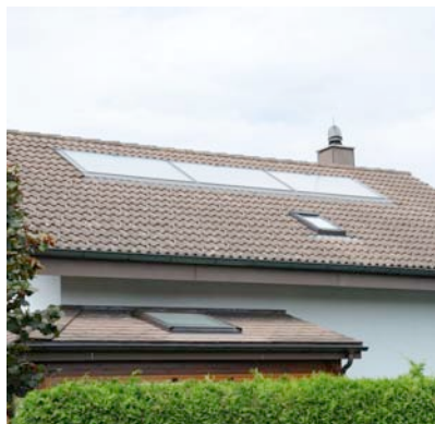
7.5m 2 Flachkollektoren 3x1H.
