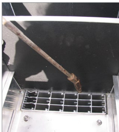
12. Alkalische Reinigung des Wärmetauschers mit geeigneten Reinigungsmittel
