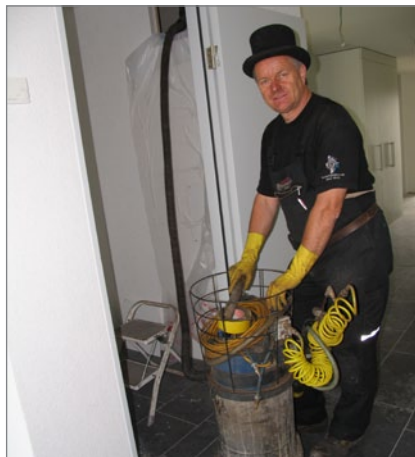
4. Der Wassersauger erzeugt Unterdruck im Lüftungsmodul
