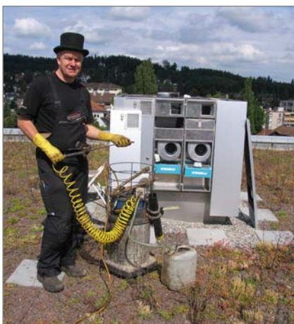
12. Alkalische Reinigung des Wärmetauschers mit geeigneten Reinigungsmittel
