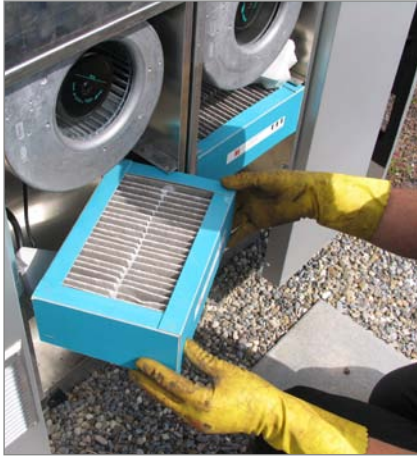
9. Ersetzen der Filter
