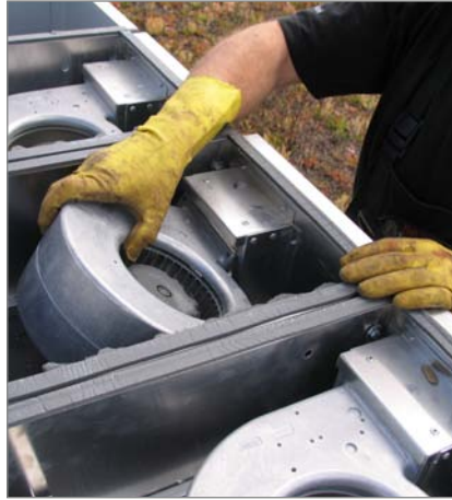
10. Netzstecker ausziehen und Ventilator entfernen
