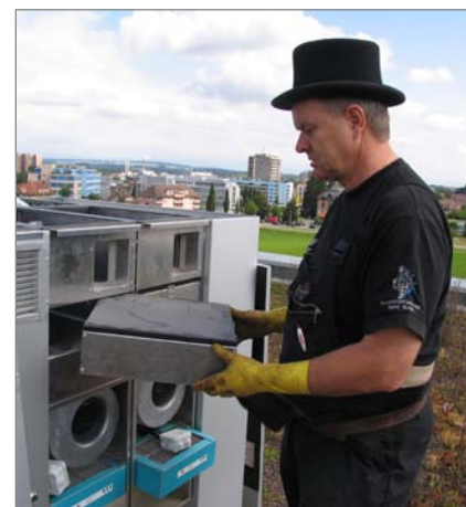
8. Entfernen der Schalldämpfer
