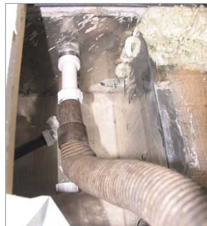
3. Wassersaugerschlauch montieren
