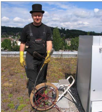
11. Mechanische Reinigung des Wärmetauschers
