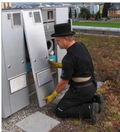
7. Entfernen der Revisionstüre
