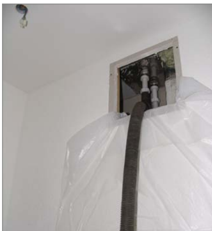
4. Der Wassersauger erzeugt Unterdruck im Lüftungsmodul
